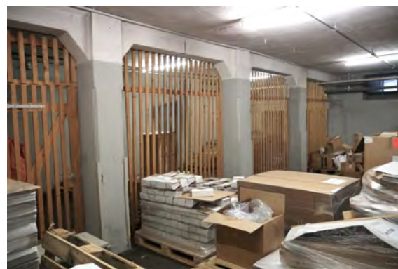
Blick auf das Tragwerk von 1903 im UG [G1] „Lagerkeller“
