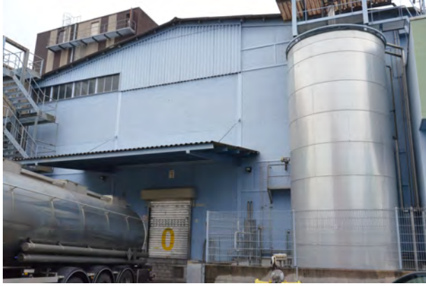
Ansicht Ostfassade, Zustand 2018
