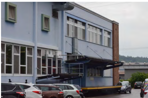
Ostfassade Gebäude B1, rechts im Bild
