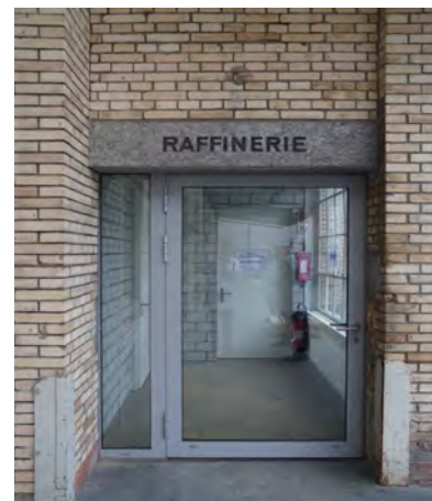
Eingang zur Raffinerie über Rampe vor [G1]
