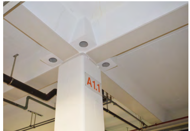
Gebäude B2, Stütze mit Unterzug
