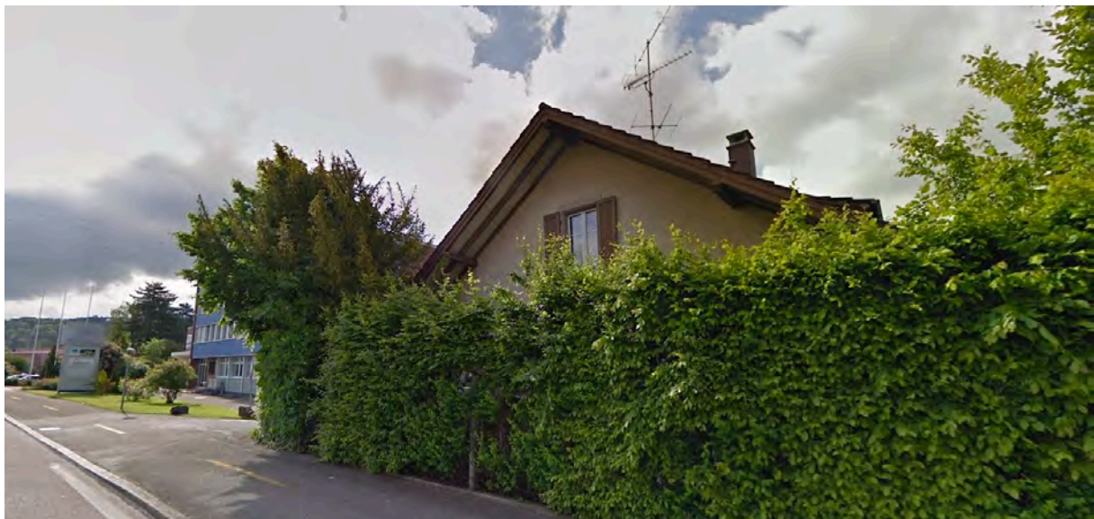
Ansicht von der St. Gallerstrasse gegen Osten © Googlemaps
