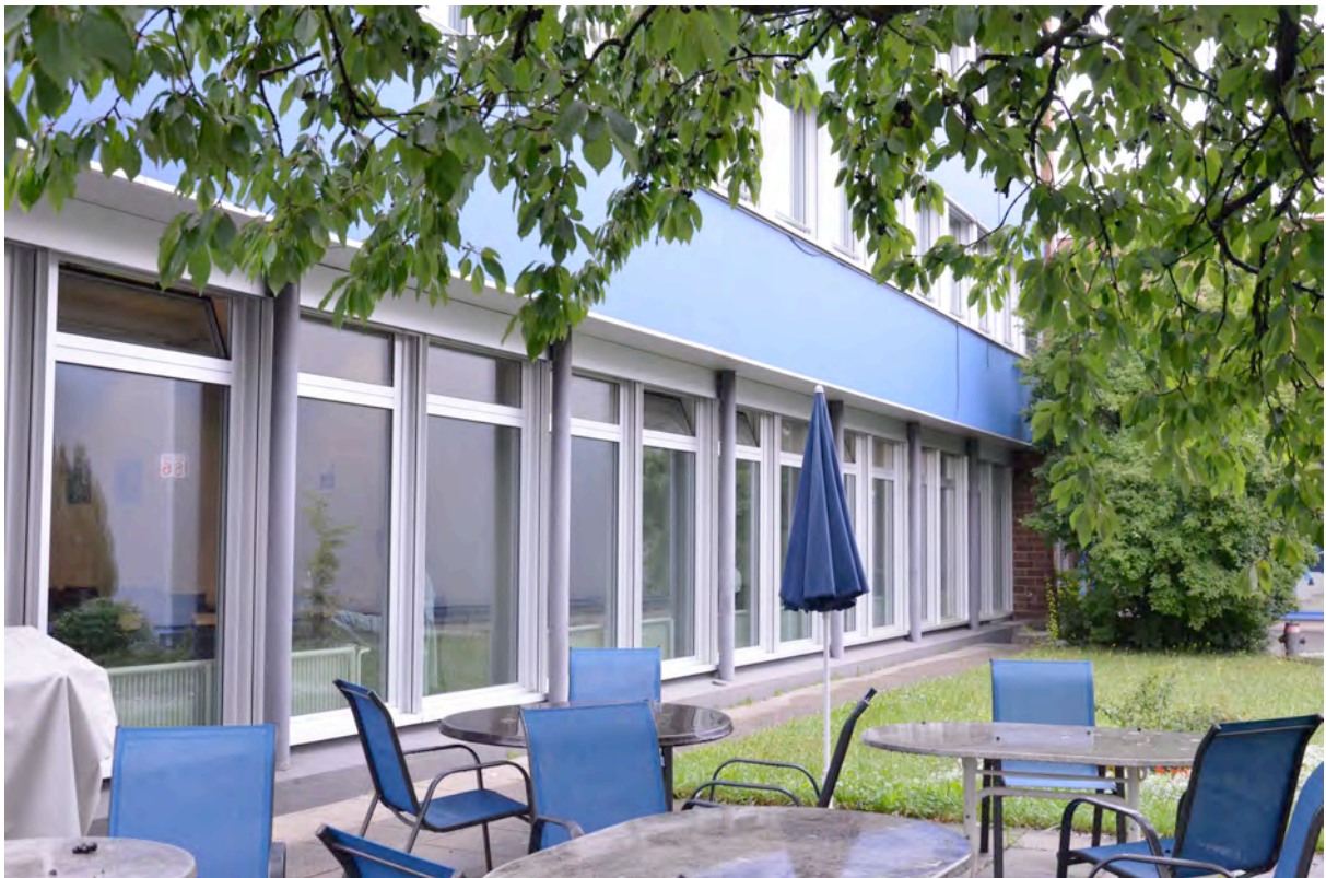
Erdgeschosszone der Südfassade im Kantinenbereich mit bauzeitlicher Befensterung
