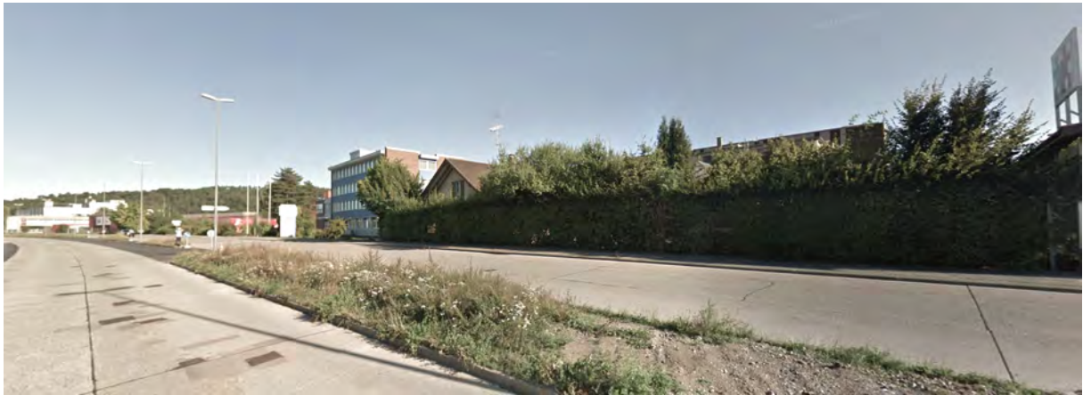
Strassenraum, oberer Fassadenbereich des Hochregallagers sichtbar; Blickrichtung Ost, © Googlemaps
