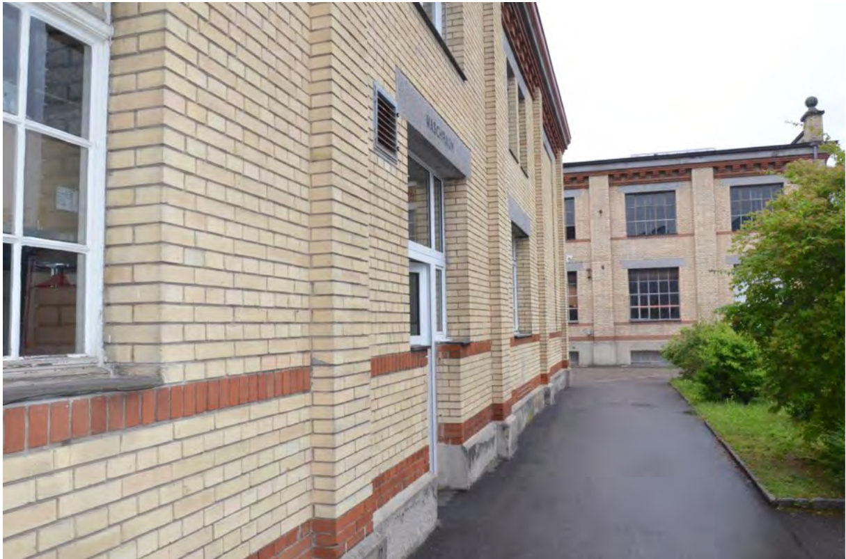
Blick Richtung Ost entlang der Nordfassade zum vorspringenden Gebäudeteil G2 und G3 der Fabrikationsanlage
