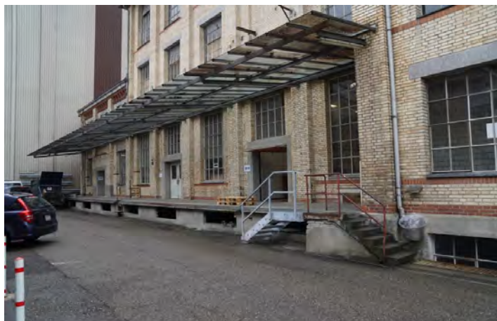
Gebäude [G1], Blick entlang der Ostfassade
