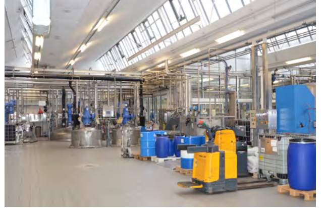
Gebäude B2, Sheddachhalle OG
