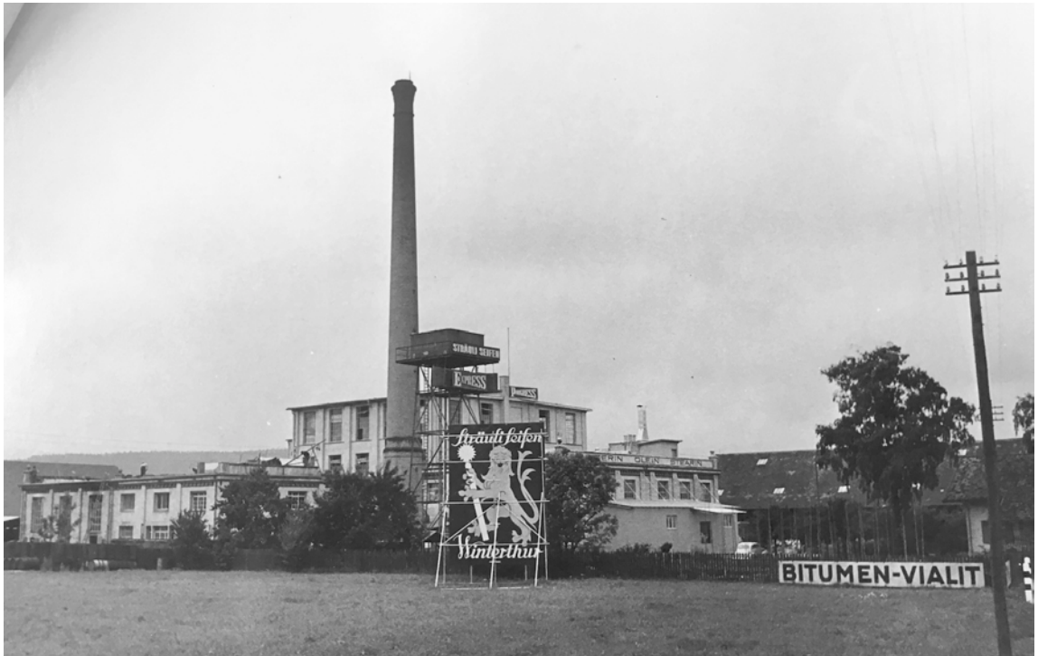
1952: Ansicht von der St. Gallerstrasse: Im Hintergrund das aufgestockte Stearingebäude mit eingewandertem Vordach gegen Norden (Umbau von 1952, später entfernt), im Vordergrund auf noch unbebautem Gelände eine Werbetafel mit Firmenlogo. Dahinter der Wasserturm von 1910 (Baupolizeiamt Winterthur)
