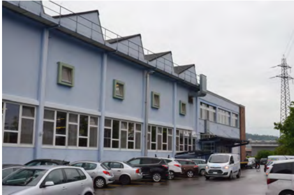
Ostfassade Gebäude B2, links im Bild, Blick nach Norden
