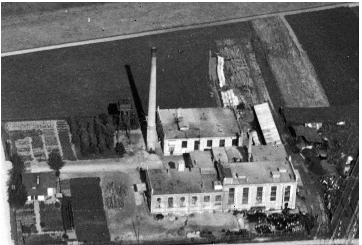
Luftbild 1919 (Ausschnitt): Das Maschinen- und Kesselhaus wurde an der nordöstlichen Gebäudecke bereits erweitert – im Dach ist der neuere Bereich gut ablesbar. Die nordöstliche Erweiterung der Stearinfabrik steht kurz bevor. (ETH Bildarchiv LBS_MH03-1744)
