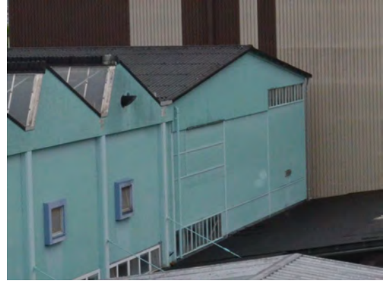
Ansicht Westfassade, Zustand 2018
