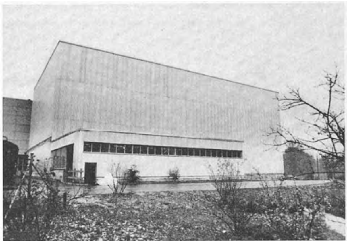
Bild 1. Webmaschinen- und Palettenhochregallager mit Anbau. Gesamtansicht von Norden. Länge (für beide Lager) 54,7 m, Breite Webmaschinenlager 21,1 m, Breite Palettenlager 8,6 m, Höhe (für beide Lager) 21,8 m
