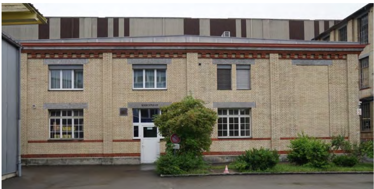
Blick auf Nordfassade der Gebäudeteile E2 (links im Bild, erstellt 1919) und E1 (rechts im Bild, erstellt 1903)
