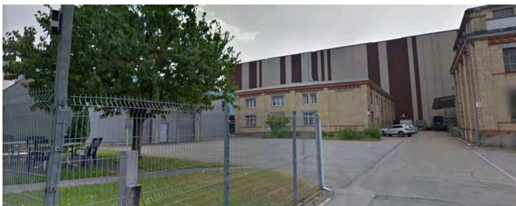
Ansicht vom Hofraum mit Nordwestfassaden
