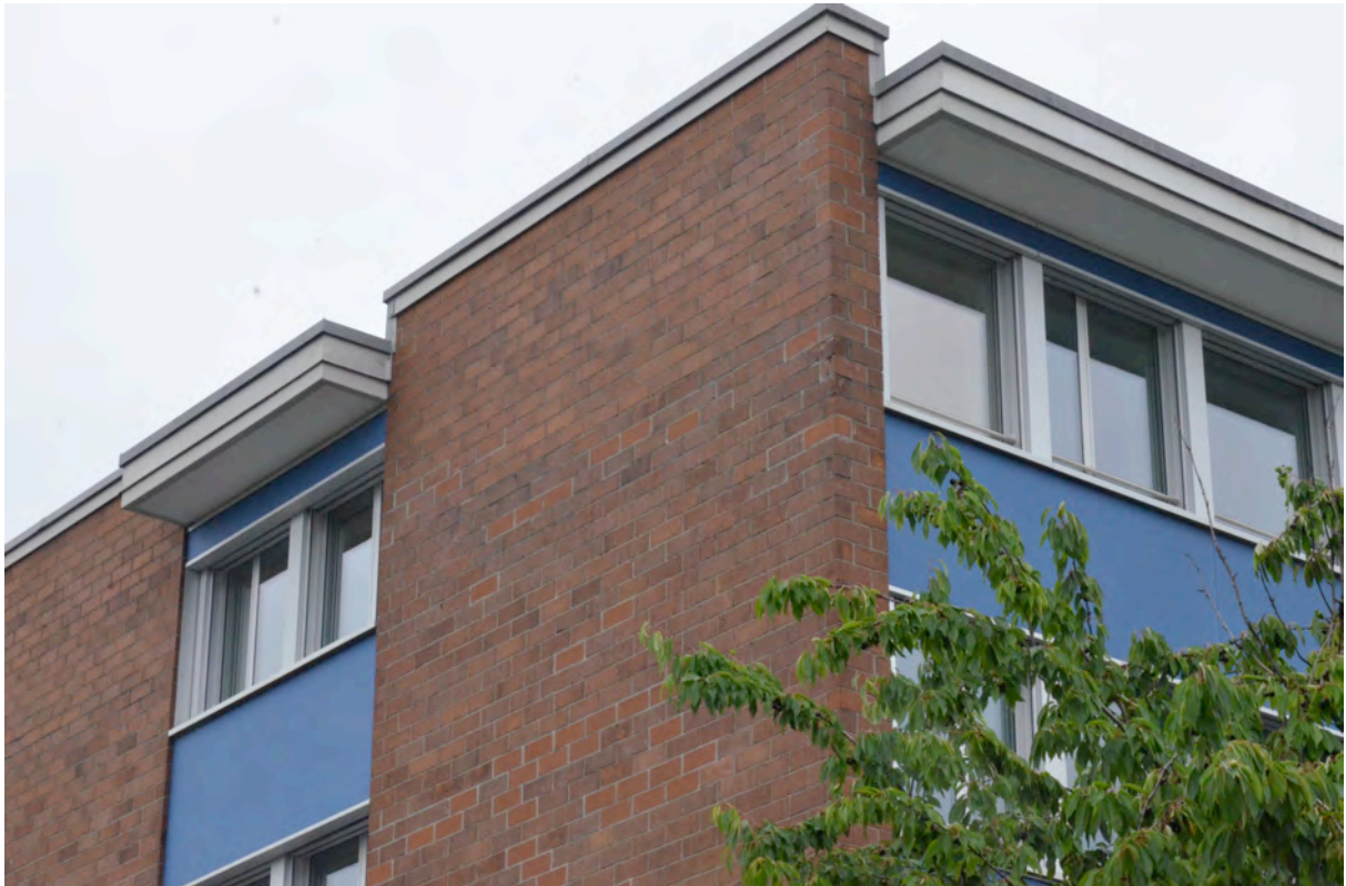
Gebäude A1, Detail – geschlossene Wandscheiben aus rotem Sichtbackstein überhöhen den stufig profilierten Dachrand & vorkragende Fensterpartien des Flachdachs
