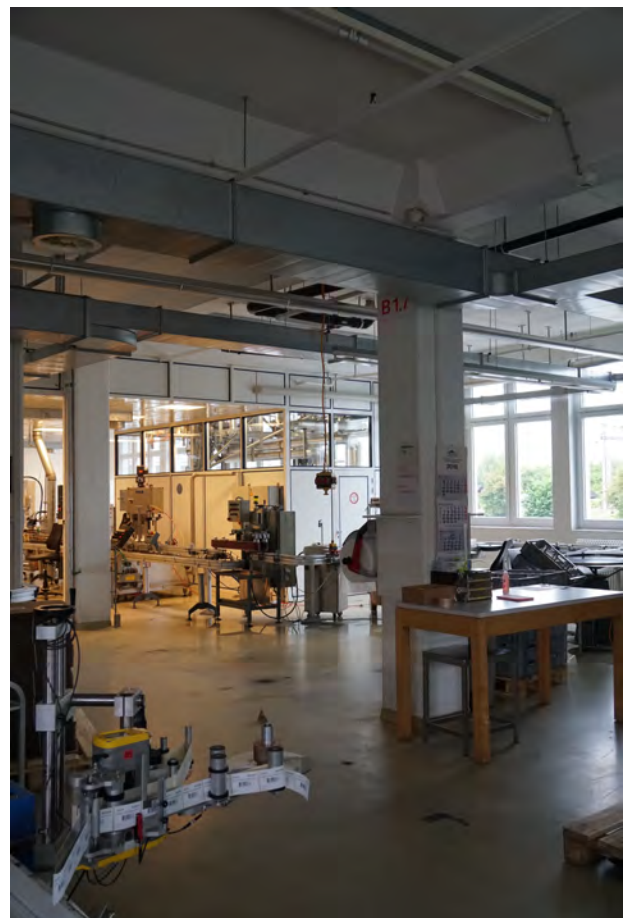
Gebäude B1, Produktionstätte im EG (Baupolizeiamt Winterthur)
