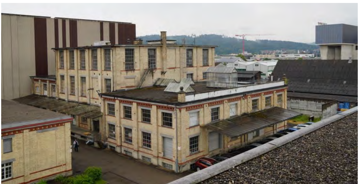
Blickrichtung Süd aus erhöhter Lage (vom Dach des Bürogebäudes [A1])
