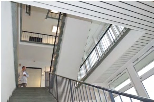
Treppenhaus mit Deckenuntersichten
