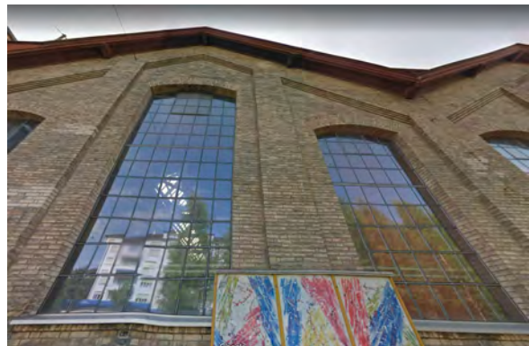
SLM-Gründerfabrik des Architekturbüros Jung/Bridler/ Völki, Zürcherstrasse 41
