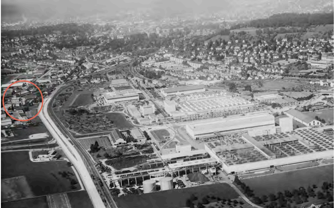
Luftbild vom 4.8. 1961: Das Sträuli Fabrikareal südlich der St. Gallerstrasse. Nördlich davon erstreckt sich das weitläufige Areal der Sulzer, seit den 1950er Jahren massiv ausgebaut, (ETH Bildarchiv, LBS_H1-022561)
