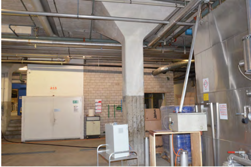
Lagerhalle UG mit pilzförmiger Stütze
