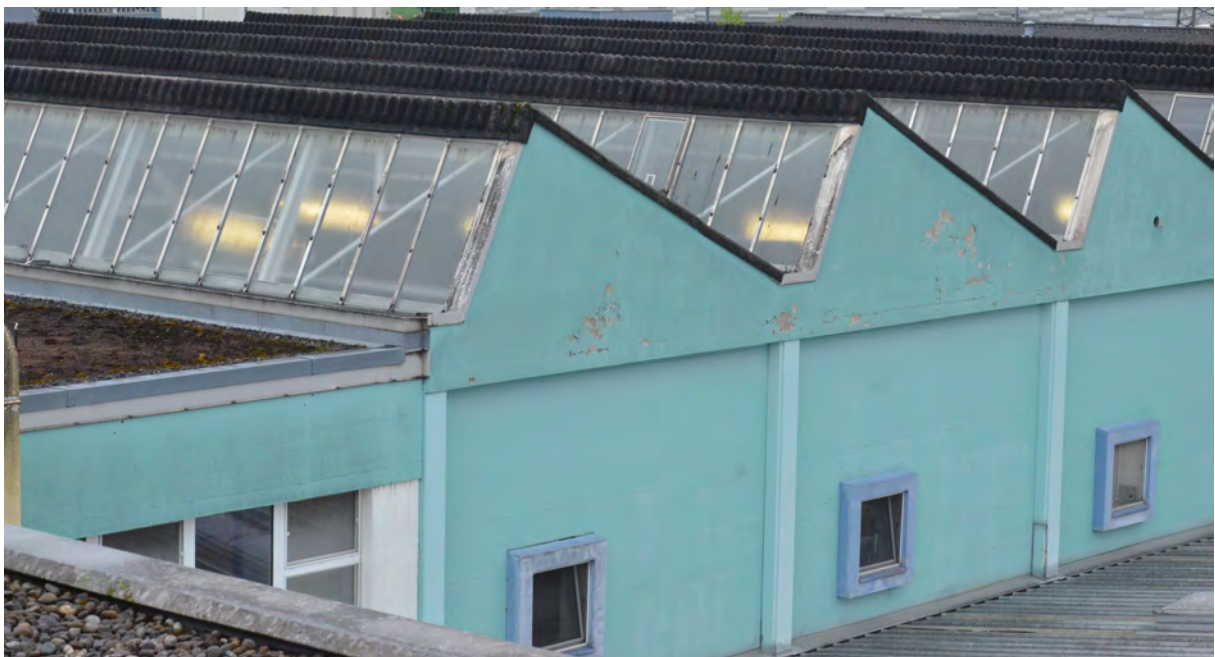
Westfassade mit Sheddach
