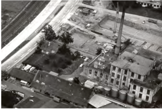
Luftbild 1962 (Ausschnitt): Zu erkennen sind die Baugruben für die neuen Bauten (ETH Bildarchiv Com_F62-00012)
