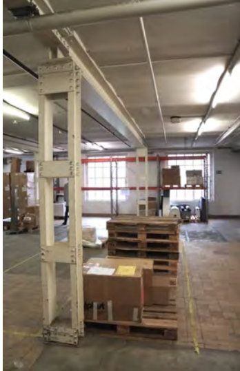
Blick auf das Tragwerk von 1920 im EG von [G3] „Raffinerie“
