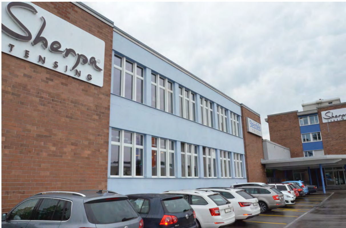
Nordfassade des Kopfbaus [B1], Zustand 2018
