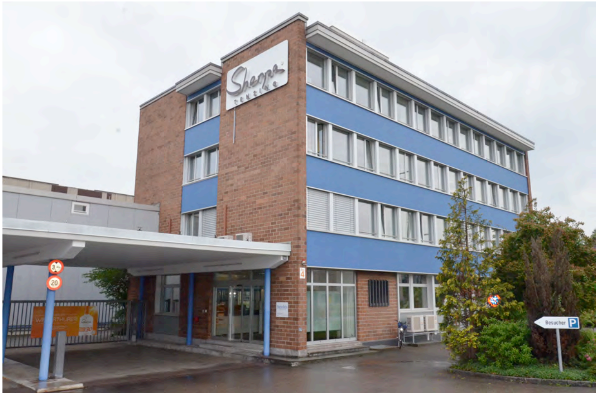
Gebäude A1, Nordostansicht
