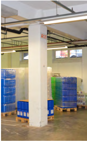
Gebäude B1, UG, Lager, Stütze
