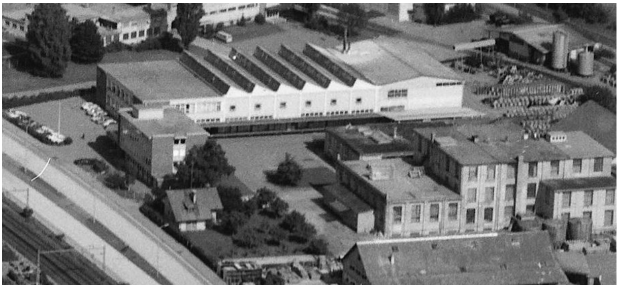
Luftbild 1971 (Ausschnitt): Die Raumkanten N, S und W werden durch Bauten formiert und bilden einen Innenhofraum (ETH Bildarchiv LBS_H1-029367)
