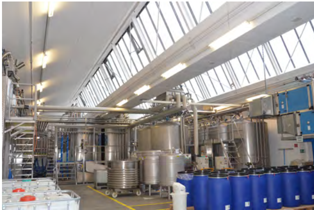
Gebäude B2, Sheddachhalle OG
