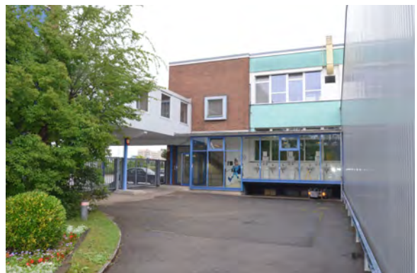
Westfassade Gebäude B1
