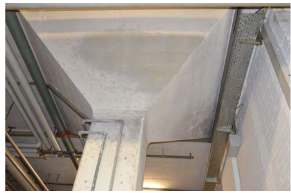
UG, pilzförmige Stütze
