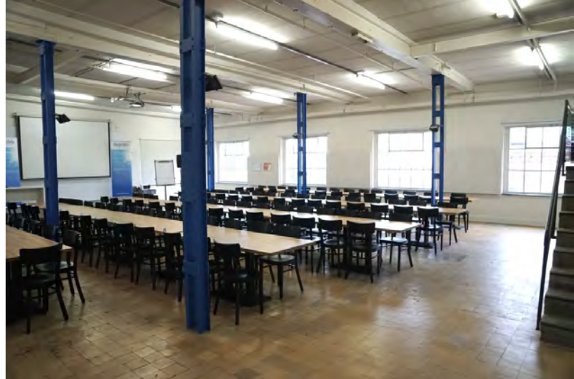
Blick auf das Tragwerk von 1920 im OG [G3] „Saal“
