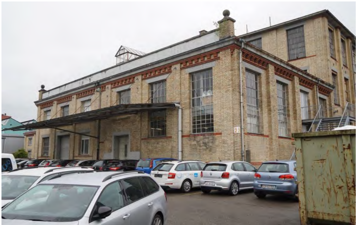
Blick auf Nordfassade der Gebäudeteile G2 und G3
