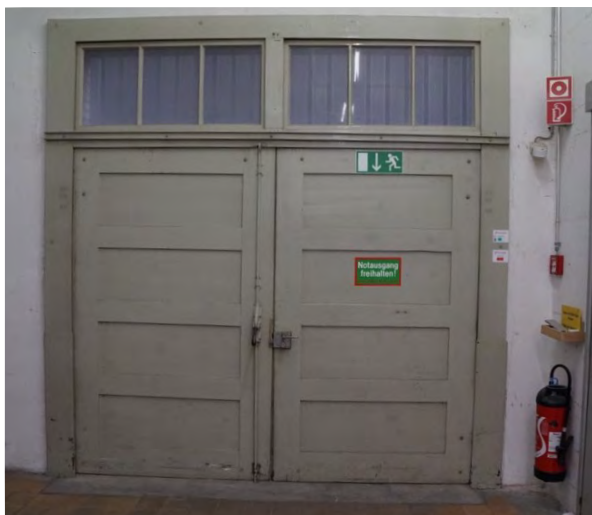
Bauzeitliches Tor (Südfassade [G5])
