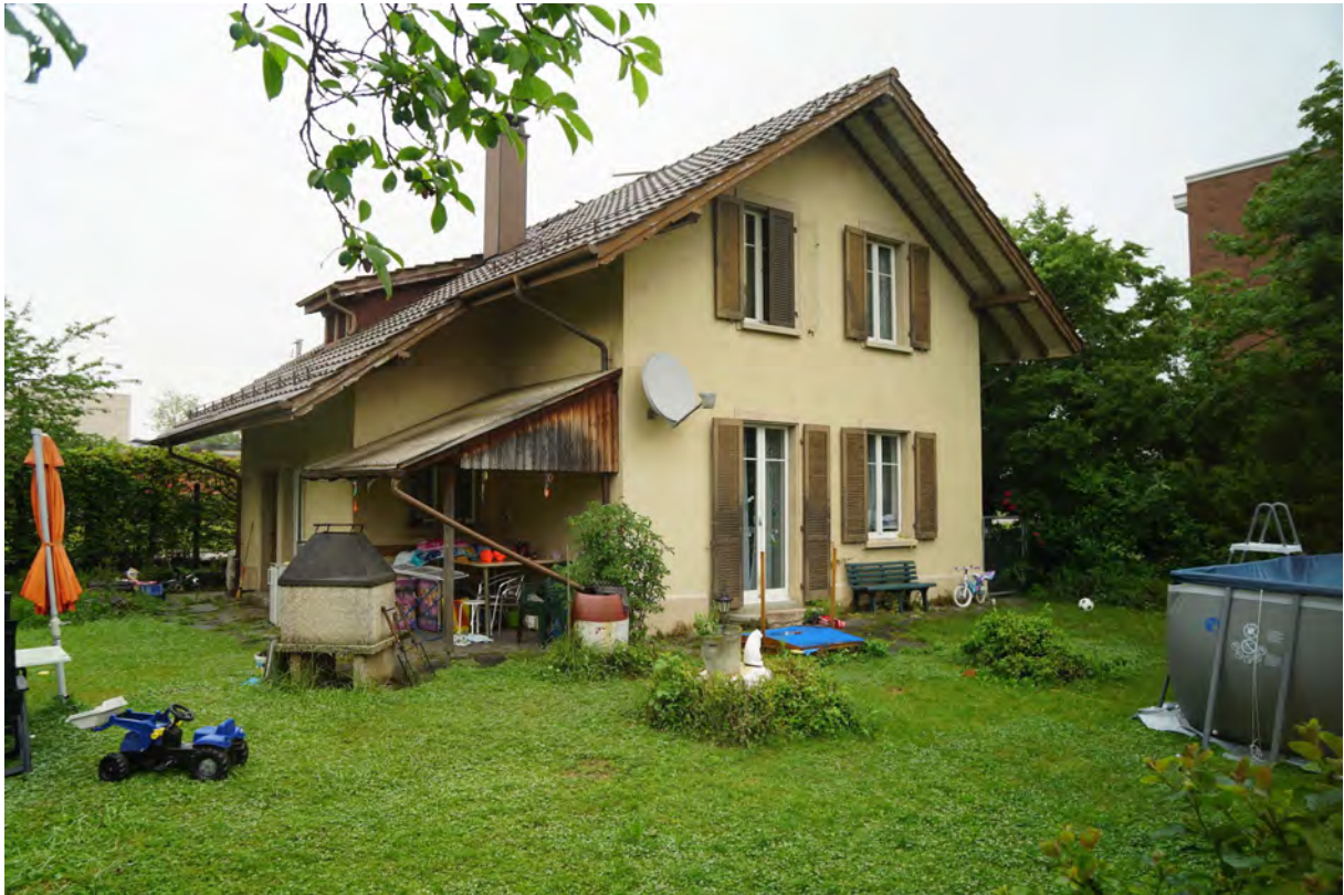
Südwestansicht, Blick aus dem Bürocontainer in den Garten
