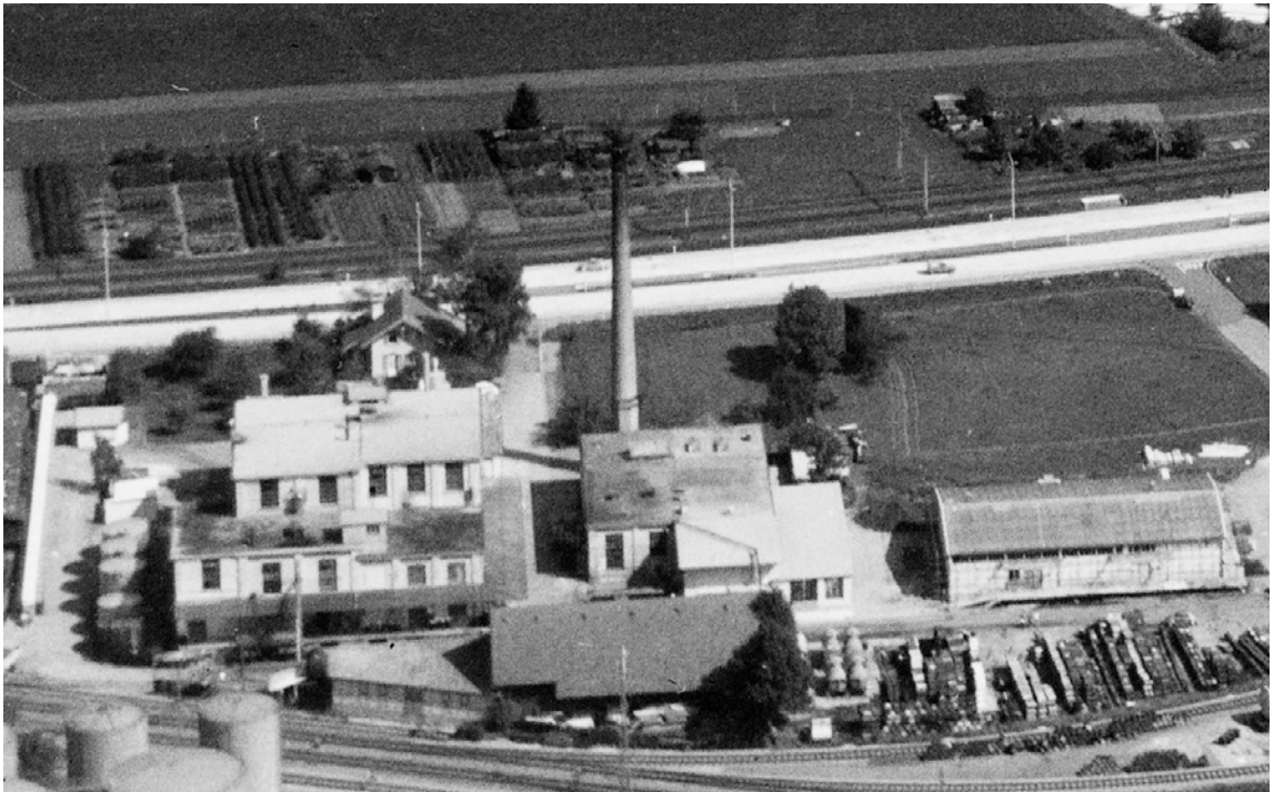
Luftbild 4.8. 1961 (Ausschnitt), Fabrikansicht mit der freistehenden eingeschossigen Lagerhalle im Osten. Gut zu sehen ist auch die 1960 erstellte südöstliche Erweiterung des Werkstatt- und Laborgebäudes. (ETH Bildarchiv LBS_H1-022562)
