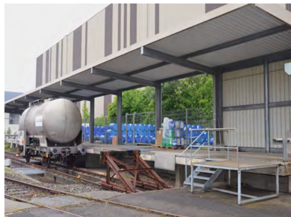
Blickrichtung West: Überdachte Bahnverladerampe
