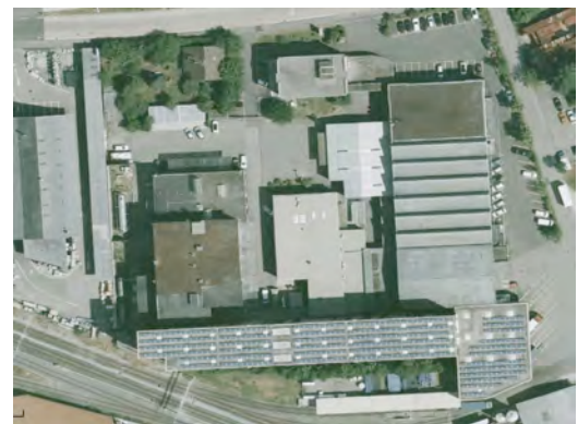
Luftbild 2014/15: Hochregallager (HRL), Spedition PV-Anlagen. (GIS/Swissphoto)
