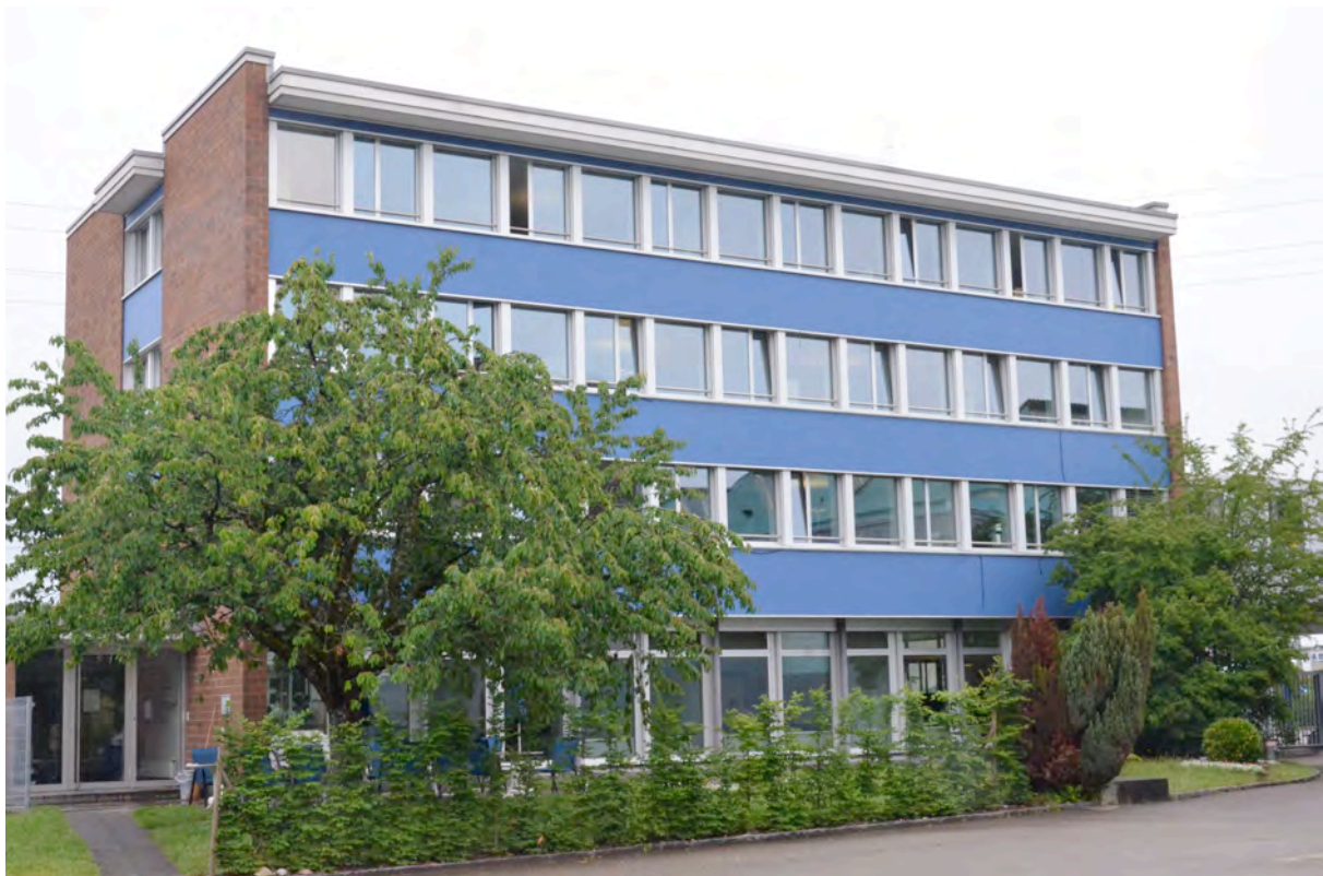
Gebäude A1, Südwestansicht
