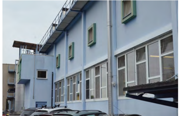
Ostfassade Gebäude B2 mit vorgelagertem Treppenhaus, Blick nach Süden
