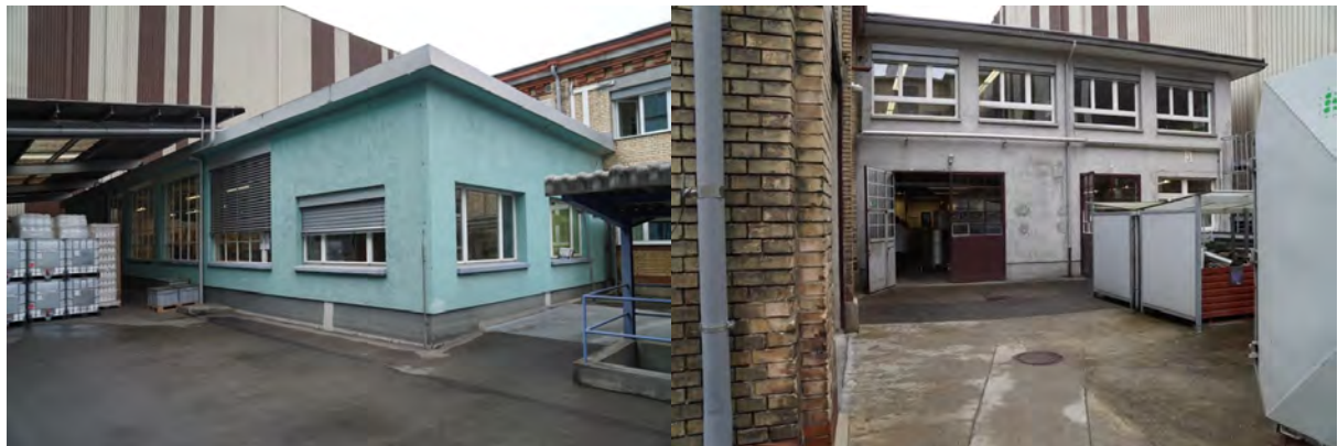
Blick Südwestrichtung auf Erweiterungstrakt bei E3
