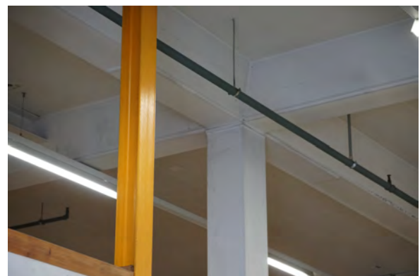
Lagerhalle, EG mit Betonbalken auf Betonstützen
