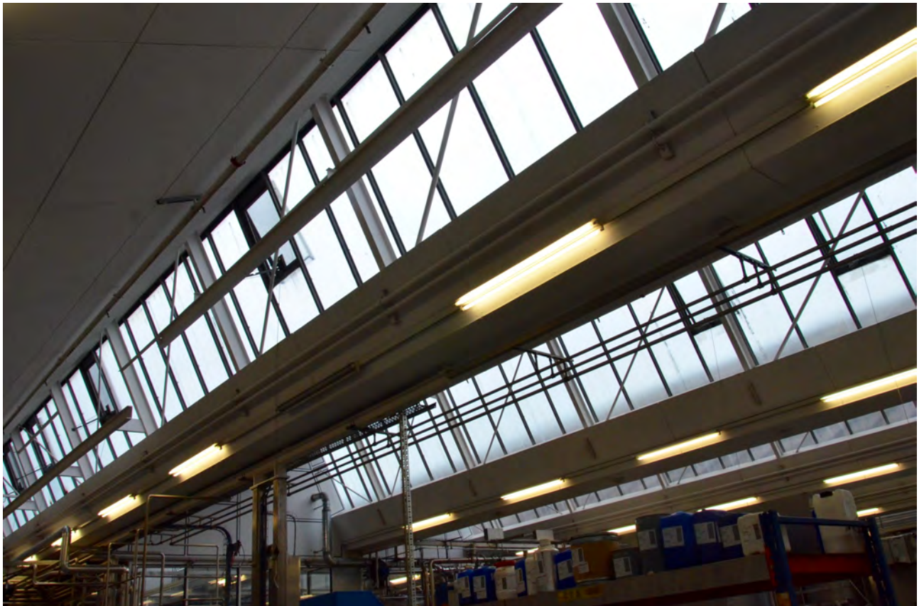
Gebäude B2, Sheddachhalle OG
