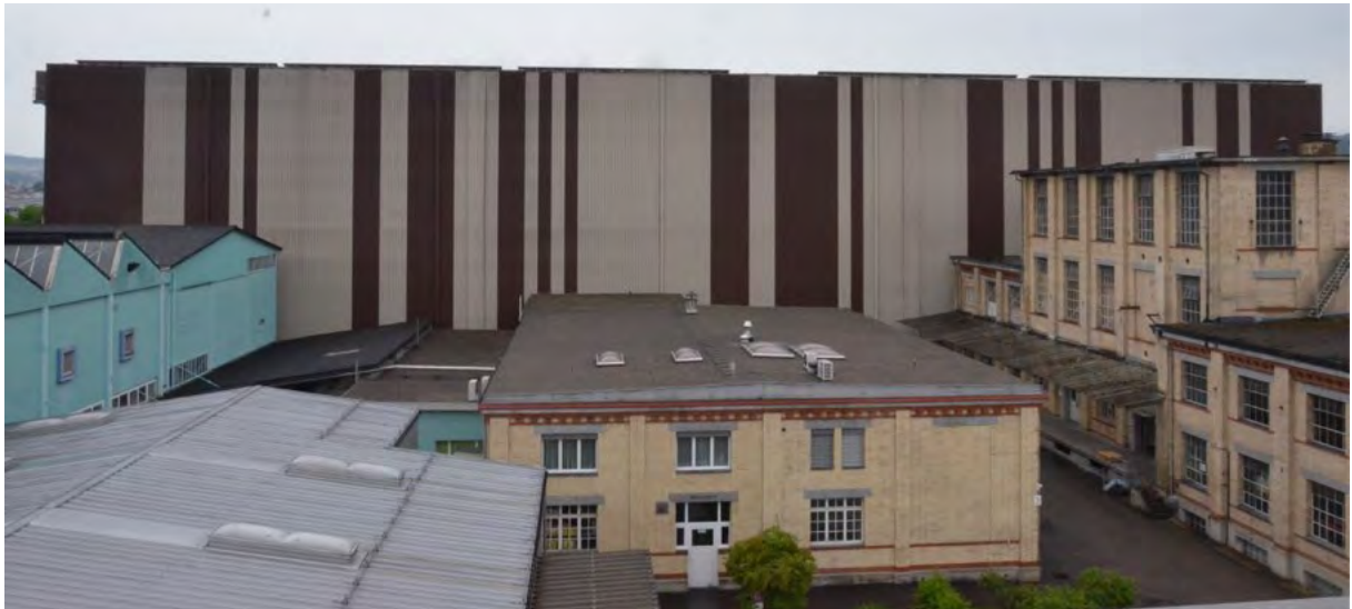
Blickrichtung Süd, von erhöhter Lage (vom Dach des Bürogebäudes [A1])
