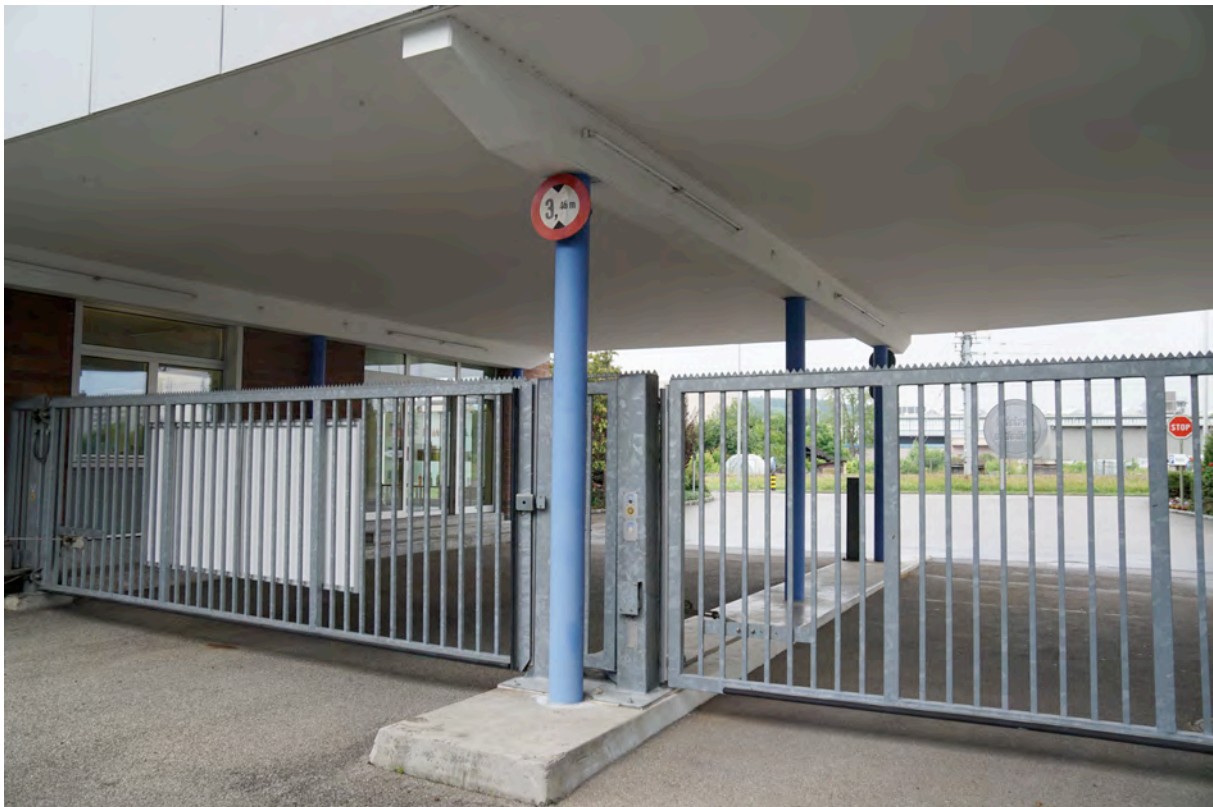
Durchfahrt mit Stützen & Auflager von Passerelle und Vordach
