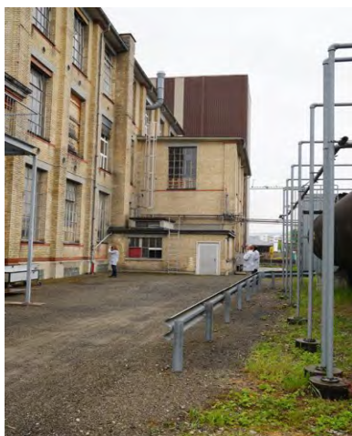
Links: Blick entlang der Westfassade 1949 aufgestockte Fassade Ofenhaus- und Lageranbau von 1948 und 1949
