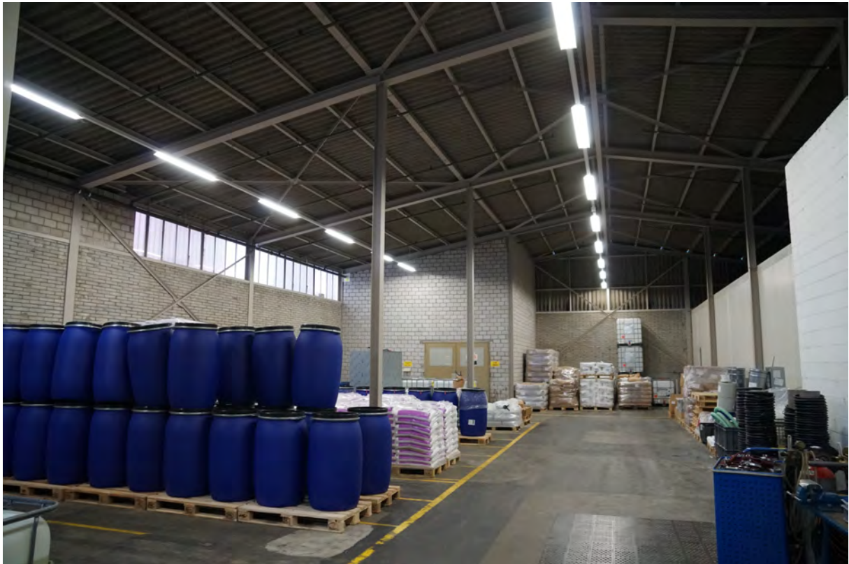
Halle OG, Tragwerk mit Stahlprofilträgern auf Stahlstützen
