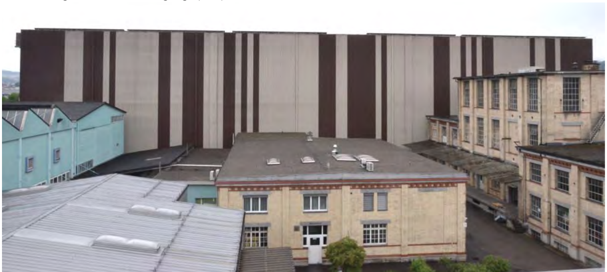
Blickrichtung Süd aus erhöhter Lage (vom Dach des Bürogebäudes [A1])
