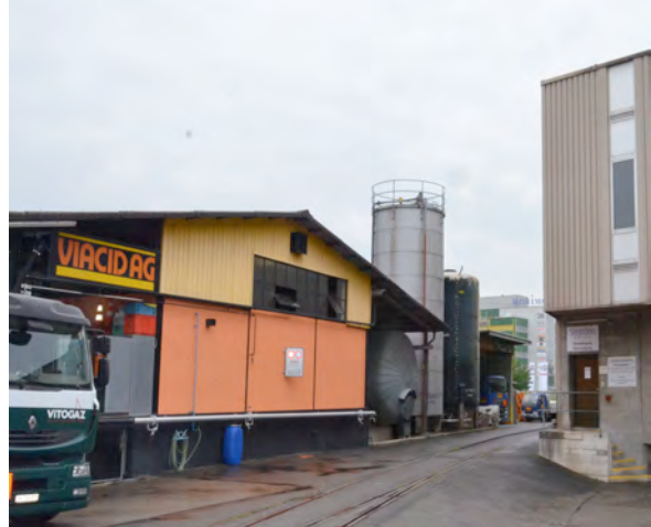
Ehem. zum Werkareal gehöriges Kaltasphaltfabrikationsgebäude (EWB)
